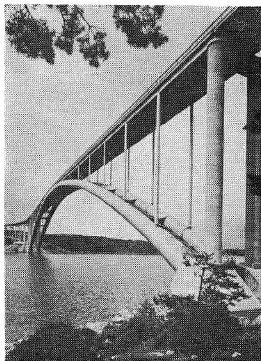
写真4 アスケレ狭橋(全長532m, 主径間278m, 両端固定アーチ, アーチ主管 3800\phi \times 14 \sim 22 )
