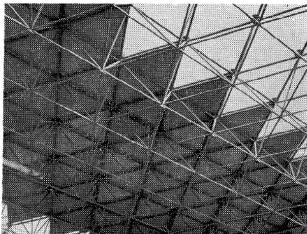
写真3 立体トラス(オクタプラッテ構造)
