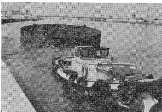
写真-1 フローティングシュー曳航
