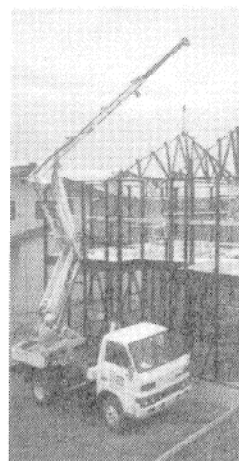
写真3 入組んだ敷地での施工を助ける為に開発したレグマクレーン
