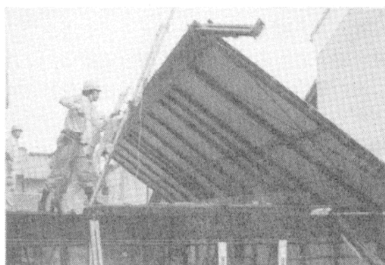
写真4 パネルリフターによる建て起こし工法。
