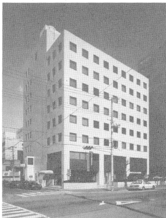
写真1 いずみビル(本社7・8階)
