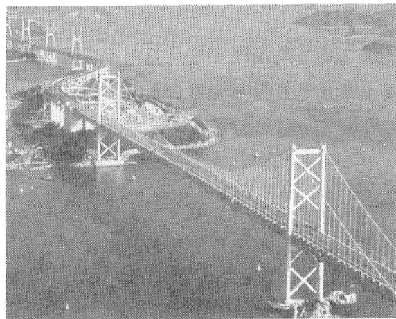
南備讃瀬戸大橋
