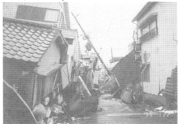
写真12 木造家屋の被害
