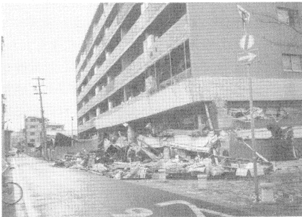
写真5 RC造建物の下層部崩壊
