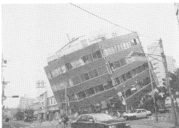
写真2 最下層崩壊により全体傾斜したRC造建物
