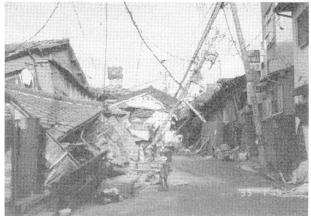
写真11 木造家屋の被害
