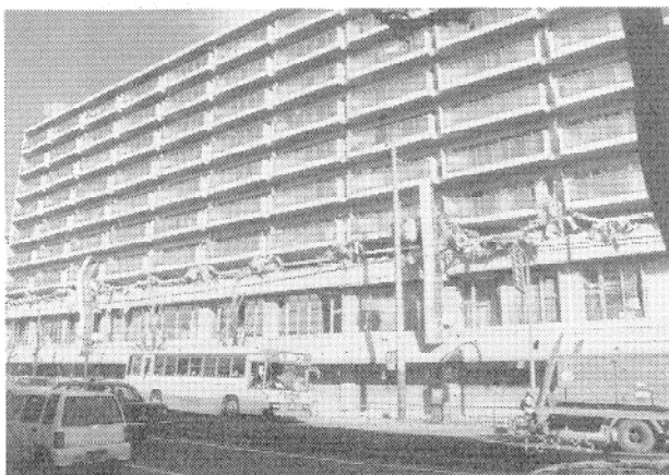
写真6 RC造建物の中間層崩壊
