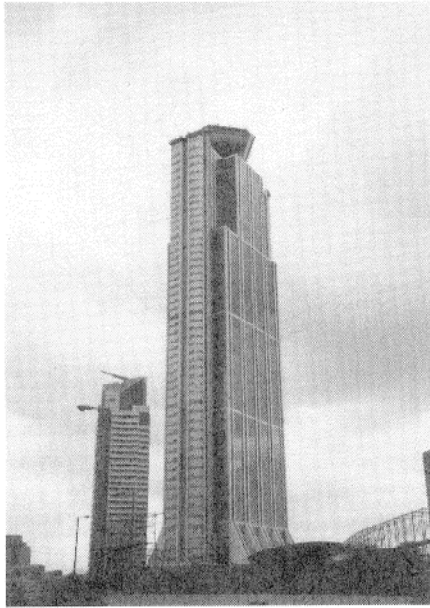
図13 多段振り型HMDの設置される超高層建物 (大阪南港コスモタワー)
