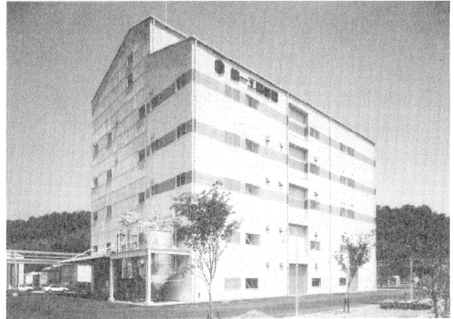
新SEプラントの外観
