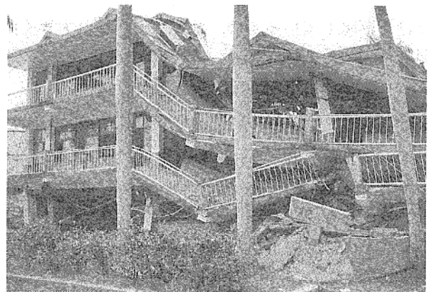
写真3 断層が校舎を横切った国民成功中学校(霧峰)
