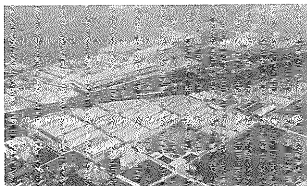
新築された当時の大阪・八尾工場(1959年/昭和34年)
