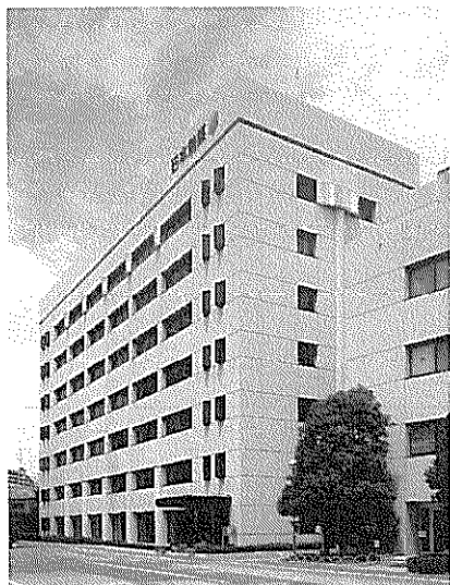
写真3 大阪府吹田市にある研究棟
