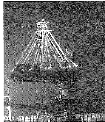
タワークレーンでクリスマスツリー
