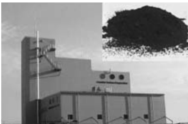
図2 工業用フラーレンとその量産プラント
