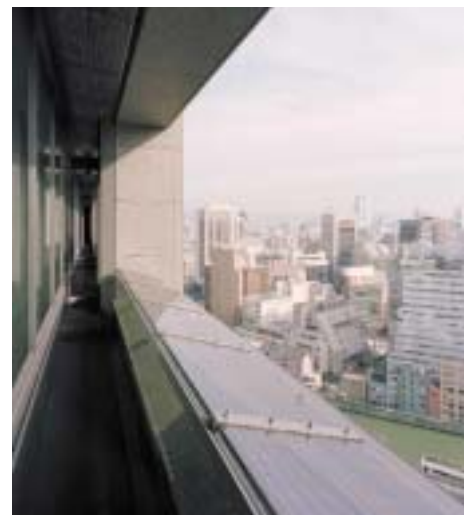
写真3 エコフレームと太陽光発電パネル
