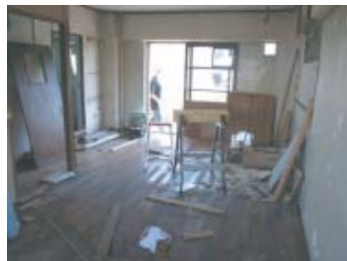
図4 改修工事中の住戸
