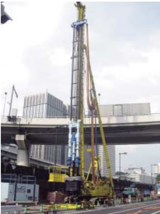
写真1 UD-HOMET工法施工機
