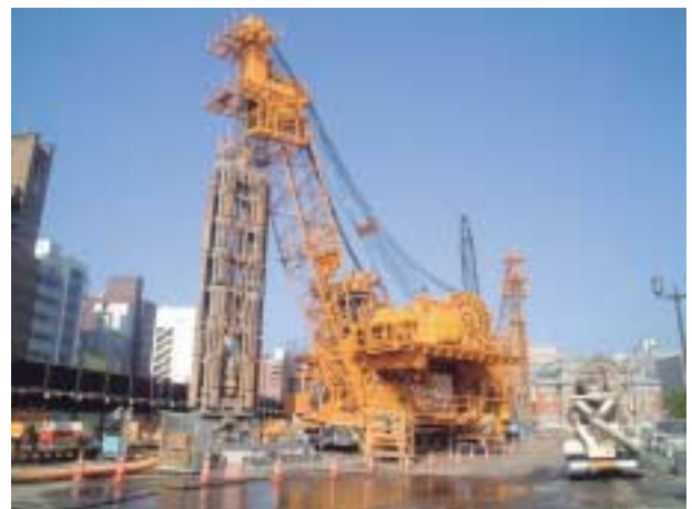
写真2 ハイドロフリーズ掘削機
