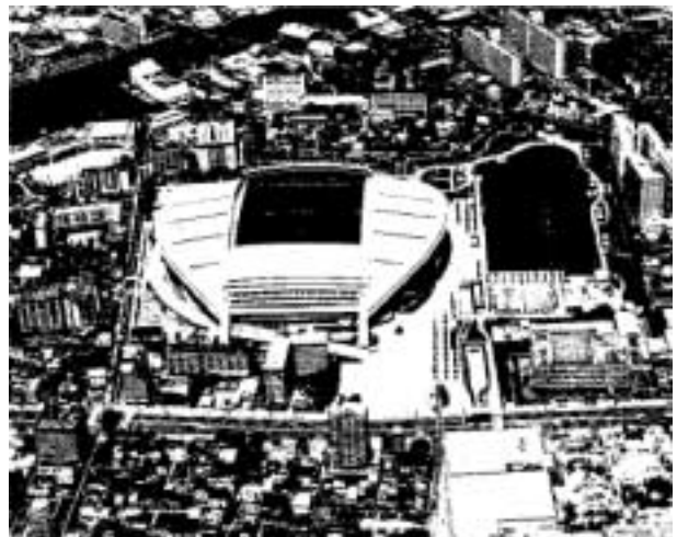
図-2 現状のスタジアム空撮 仮設席を撤去して可動屋根を設置した。
