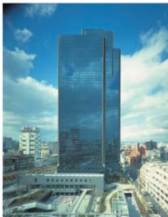
写真 - 1 梅田センタービル
