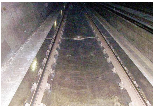
図6 浸透硬化パーミエイトの施工例 鉄道スラブ軌道
