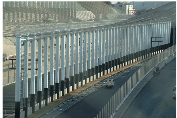
図4 パーミエイト使用施工例 第二京阪道路防護施設
