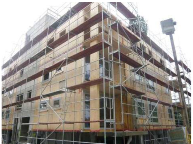
図2 建設中のアクティブハウス
