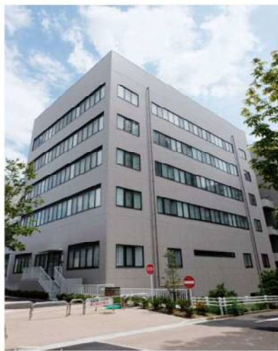
オンコロジーセンターの棟外観
