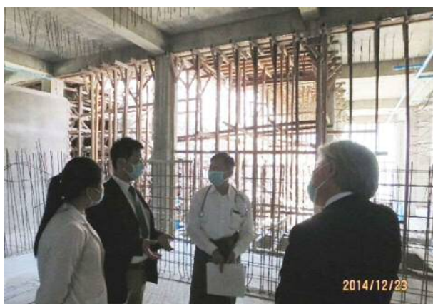
図2：ミャンマー ヤンゴン総合病院におけるPETサイクロトロン施設建設の立会い（2014年12月撮影。その後、施設は完成し、現在は運用にあたっての研修を実施中）。
