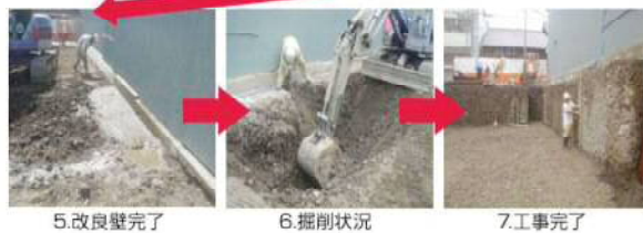
<改良体を用いて施工される土留壁の施工状況>
