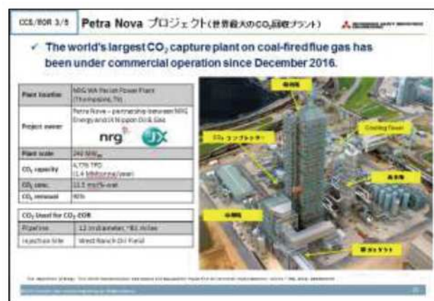
図 15. Petra Nova プロジェクト (世界最大の CO 2 回収プラント)
