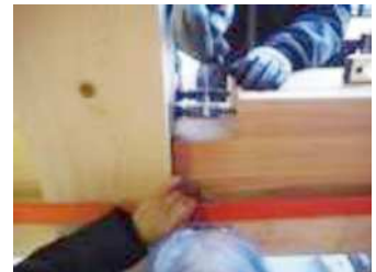
図26 締付けの様子
