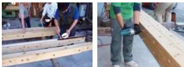
図10 組柱の組立 (左:接着材塗布、右:ラグ締付)
