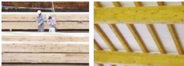
図9 現場梁積状況と施工後の重ね梁
