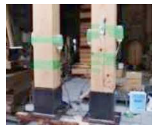
図16 樹脂注入の様子
