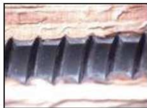
図23 樹脂充填状況
