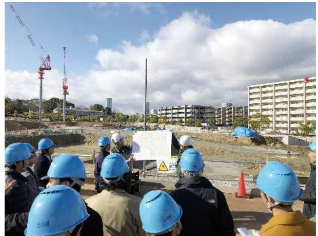
図4 グローバルビレッジ建設現場でのフィールドワーク
