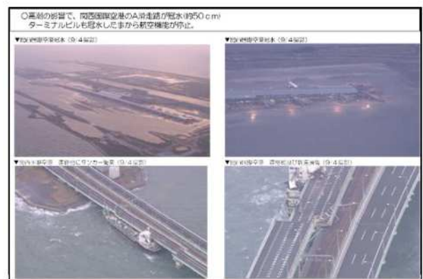
図9 平成30年9月 台風21号関西国際空港の被災状況
