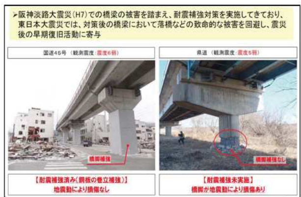
図5 東日本大震災における橋梁耐震補強の効果
