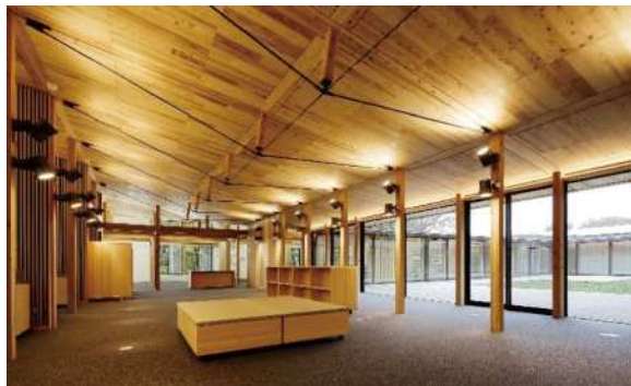
木フレームと CLT が同面に収まる盤状天蓋
