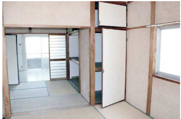
写真2 改修前の内観
