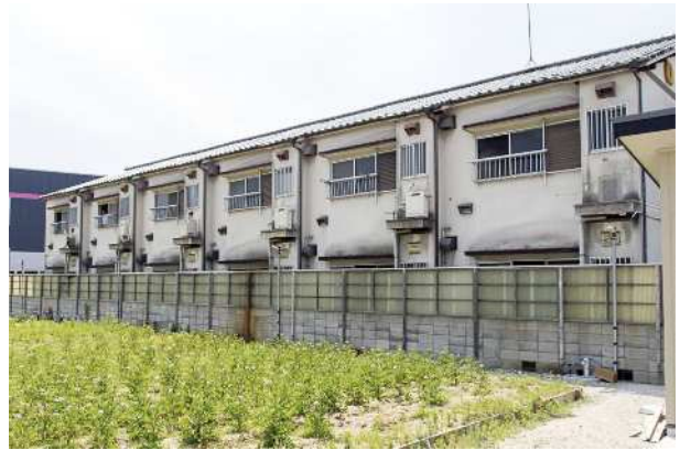
写真1 改修前の外観
