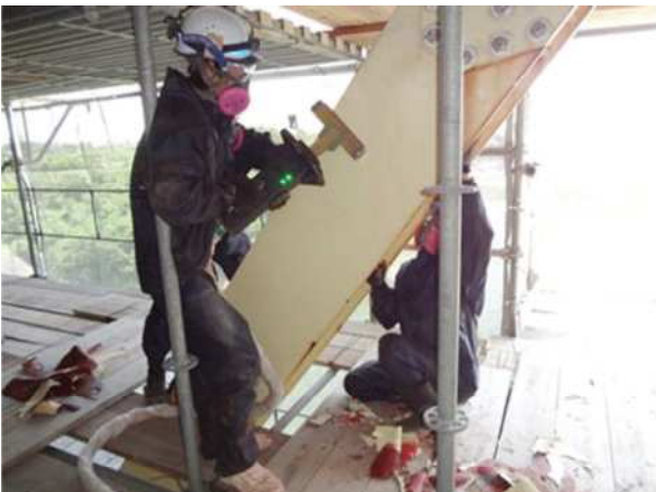
図-4 IHによる塗膜剥離
