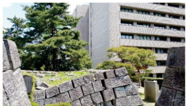
写真-5 福井城址の石垣の崩壊の跡 (左の立て札に自然への警鐘が記されている)
