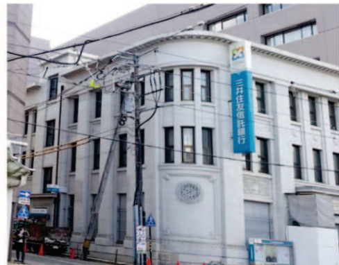
写真-4 今も使用されている無被害のビル
