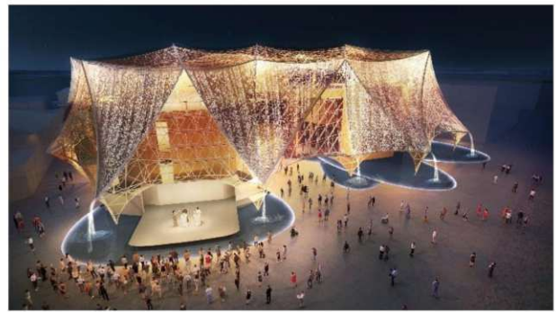
図 5 夜間は内部の光を通す ETFE 膜の屋根
