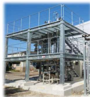
図7 メタネーション実証設備
